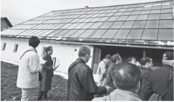
オーストリアギュッシング市の太陽光暖房設備
